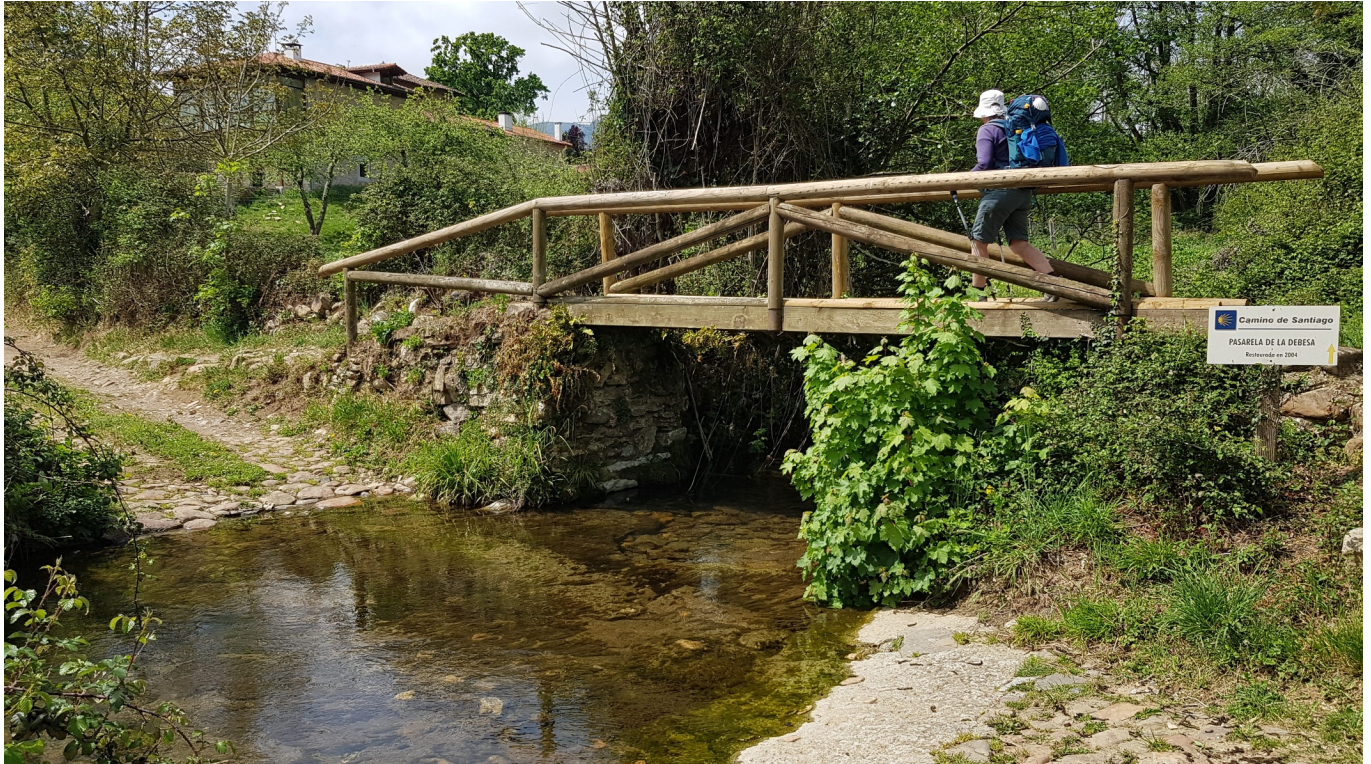
Pasarela de la Debesa
